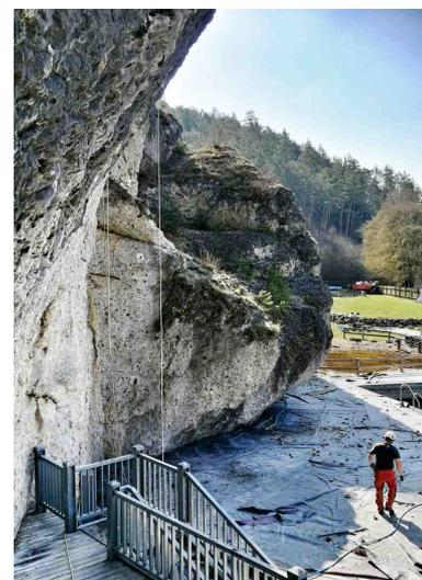
Als Weiteres wird bei der „Pottensteiner Wand“ im Löhrgäßchen am Felsfuß sowie dem oberen Abschluss der Wand ein Fangzaun installiert. Mit dieser Maßnahme wird der Gefahr von herabfallenden Steinen begegnet, die sich aus dem oberhalb der Pottensteiner Wand befindlichen Hangbereich lösen können.
