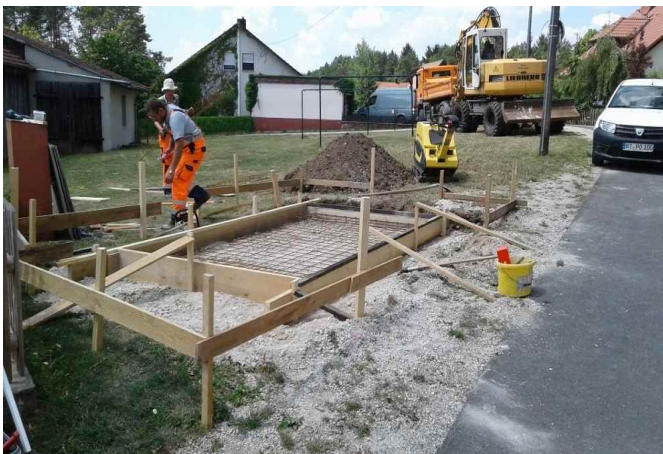
Fundamentarbeiten für das neue Bushäuschen in Weidenhüll bei Elbersberg
