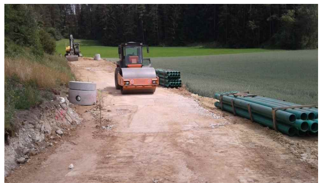
Herstellung des Unterbaus für den geplanten Mehrzweckweg von Siegmansbrunn zum Gewerbegebiet Pottenstein. Die Rohre für den Schmutzwasserkanal liegen bereit.
