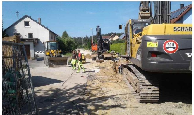
Schweres Gerät beim Kanalbau in Siegmansbrunn
