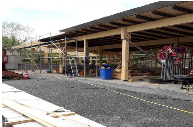
Umbau und Erweiterung der Lagerhalle am Bauhofgelände
