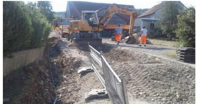
Allgemein wurde mehrfach der kurzfristige Einsatz der Bauhofmitarbeiter zur Vorbereitung der Kabeltrassen erforderlich, u. a. Weg längs der Püttlach frei schneiden, zwischen Campingplatz Bärenschlucht und dem Anwesen Ringler; Mauerabbruch und Setzen von Fertigteilen für Kabelverteilerschrank in Vorderkleebach.
