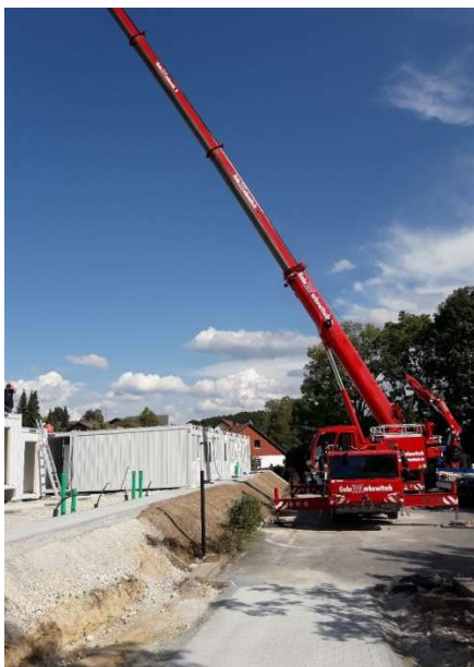
Stellen der Container
