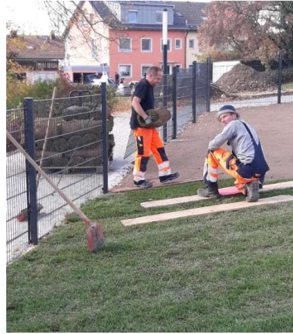
Verlegen des Rollrasens
