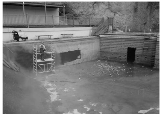
Reinigung der Teichfolie an der Beckenwand mit dem Hochdruckreiniger
