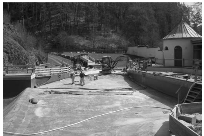
Vorbereitende Arbeiten zur Neugestaltung Einstieg zum Nichtschwimmerbereich
