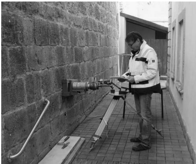
Probebelastung der Rückverankerungen an der fertigen Mauer hinter dem Kindergarten durch einen Prüfinstituts-Mitarbeiter der Hochschule Karlsruhe; alle Prüfungen mit sehr gutem Ergebnis – Prüfung der Standsicherheit: Bestanden!
